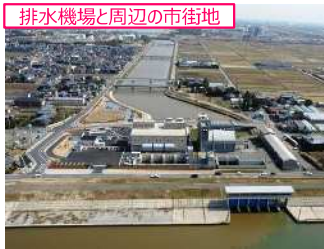
排水機場と周辺の市街地
