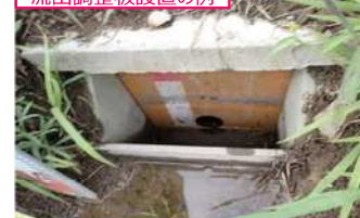
流出調整板設置の例
