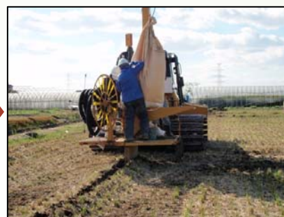
暗渠排水施工状況
