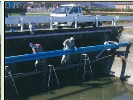
水管橋の塗装
