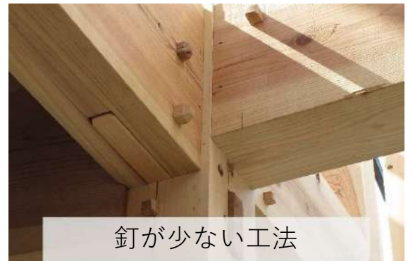
現場での棟上げ
