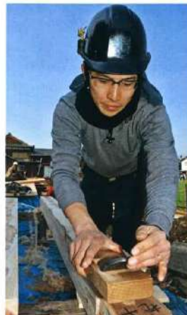
伝統工法を扱う職人
