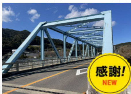
伊万里市 橋梁塗装工事
