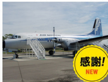
佐賀市 佐賀空港 YS-11外装塗り替え工事
