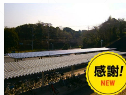
武雄市 高校 駐輪場 屋根塗装 外壁塗り替え工事
