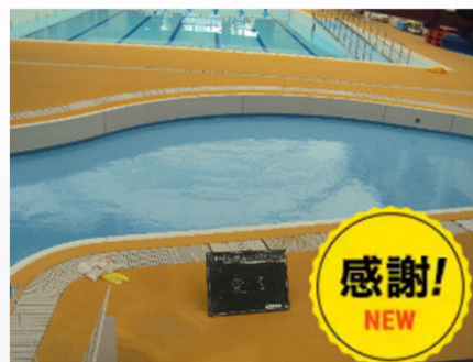
白石町 プール塗り替え工事
