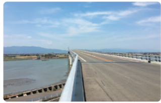
六角川大橋から芦刈南IC側を望む
