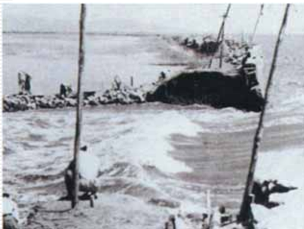
▲昭和31年8月台風9号（芦刈海岸破堤）
