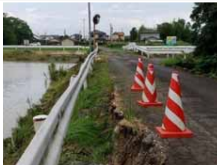
水路法面崩壊により水路に土砂流入 (通行にも支障)
