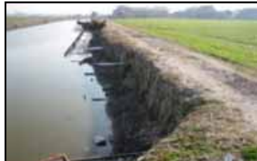
崩壊したクリーク法面
