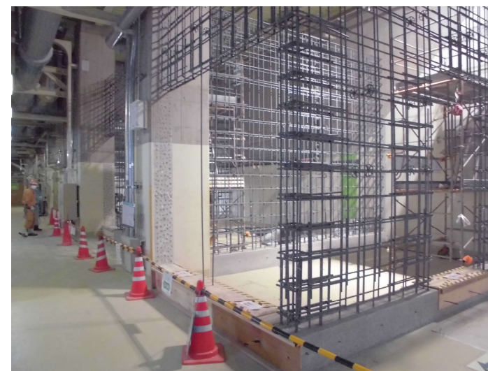
設置場所の工事状況
