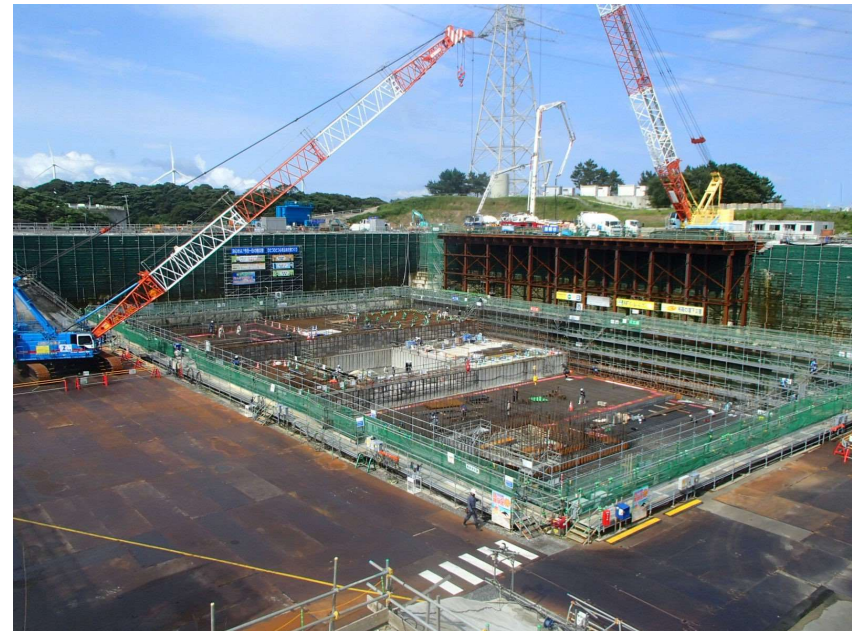
設置場所の工事状況
