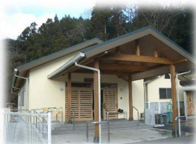
(生活介護棟 外観)
