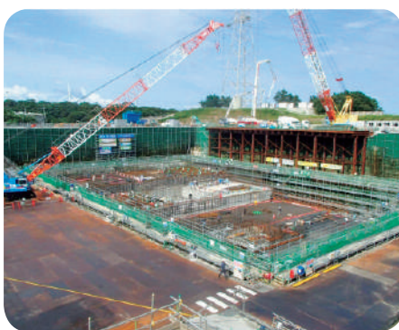
設置場所の工事状況
