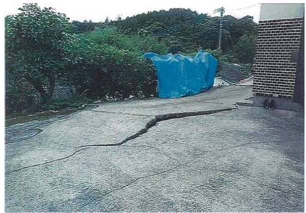
令和3年8月豪雨による宅地裏斜面のひび割れ及び宅地土間コン隆起
