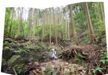
① 溪岸の侵食状況
