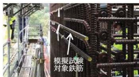
段取筋フックから落下させる前の状態
