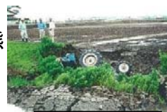
法面の崩落状況（トラクターの転落）
