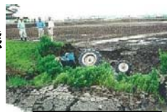
法面の崩落状況 （トラクターの転落）
