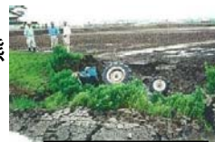
法面の崩落状況 (トラクターの転落)
