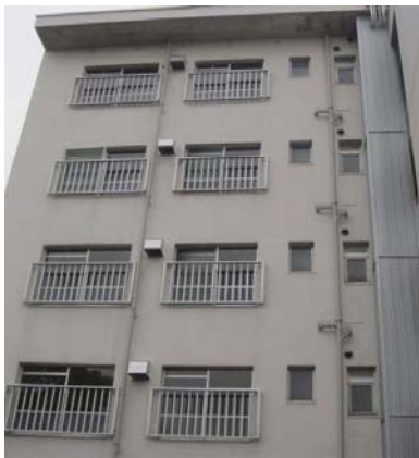
給排水設備配管改修（改善後）
