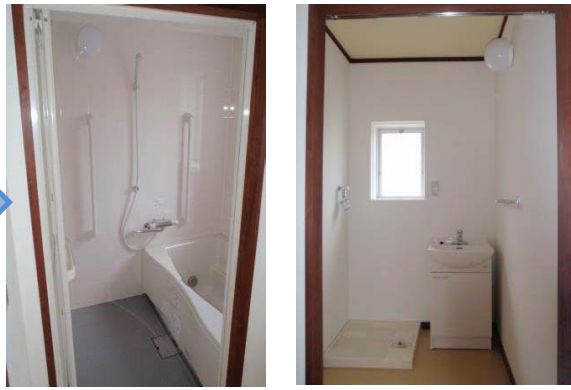
浴室・洗面所（改善後）
