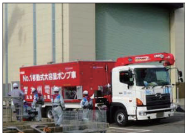
◇移動式大容量ポンプ車の設置
