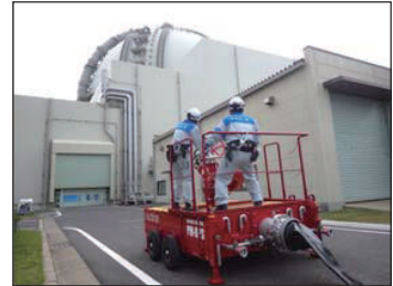
◇放水砲の設置
