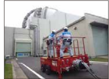
◇放水砲の設置
