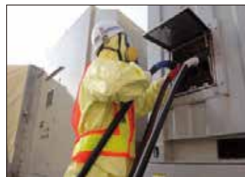
◇中容量発電機車の電源ケーブル接続 (汚染防護具着用)
