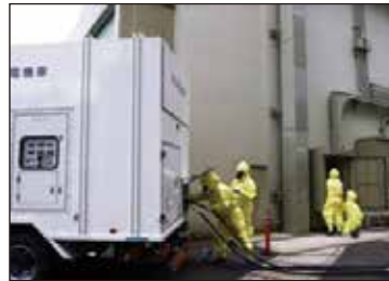
◇高圧発電機車の電源ケーブル接続 (汚染防護具着用)
