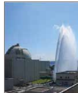
◇放水砲による放水
