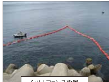
シルトフェンス設置
