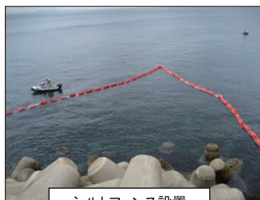
シルトフェンス設置
