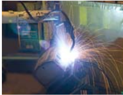
溶接ロボット
