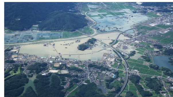
令和3年8月豪雨時の内水氾濫状況(武雄市内)
