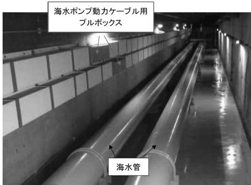
【海水管トレンチ内部】
