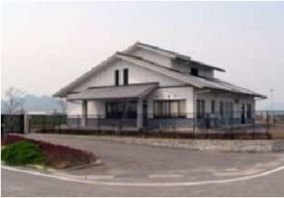
農業集落排水処理場 【白石町 牛屋西分地区】
