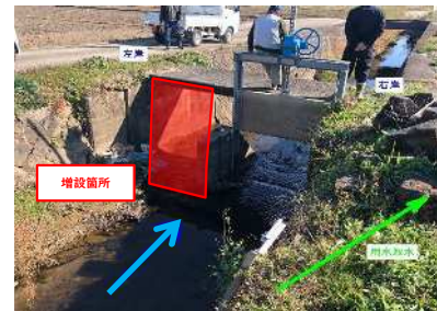
制水門の増設（予定） 【西宮裾地区 武雄市】
