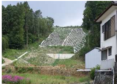
工事完了 (嬉野市 井手川内地区)
