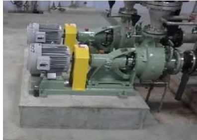
圧送ポンプの更新 【武雄市 橋下地区】
