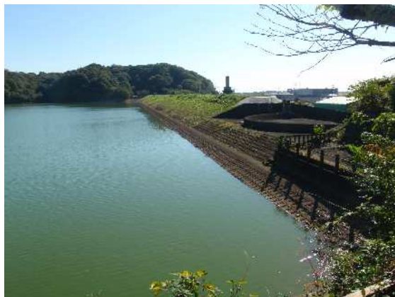
整備前【武雄市 焼米地区】
