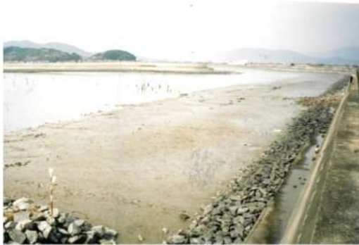
堤防嵩上げ・補強 整備前 【白石町 廻里江地区】
