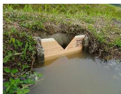
堰板設置状況
