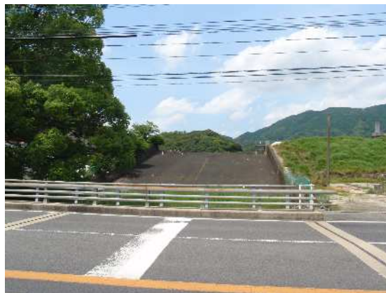
整備前（余水吐の状況）【武雄市 焼米地区】
