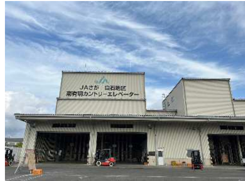
米麦生産の基幹施設カントリーエレベーターの整備【管内全域】
