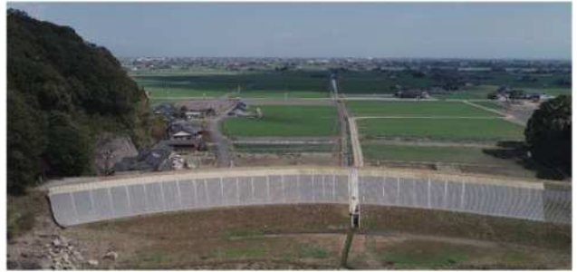
整備済（堤体・取水施設等完成状況） 【白石町 坂田地区】
