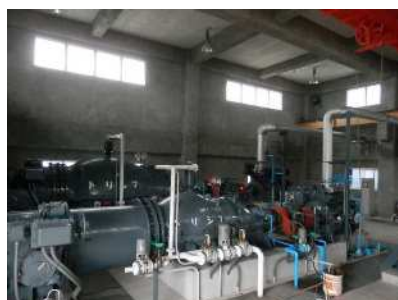
排水機場（ポンプ設備）の改修 【鹿島市 鹿島2期地区】
