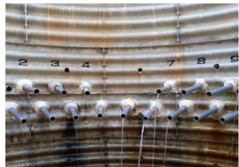
整備済（集水井内部状況・水抜き状況）
