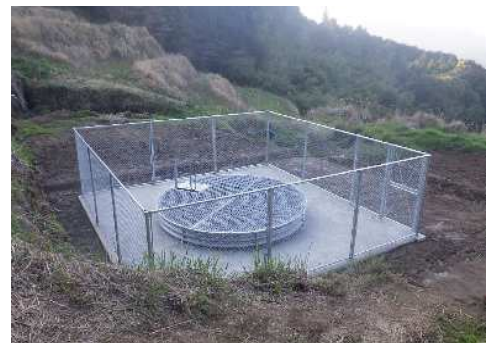
整備済（集水井の設置状況）
