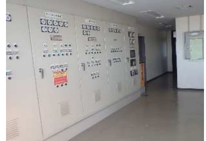
操作盤の更新 【白石町 牛屋西分地区】
