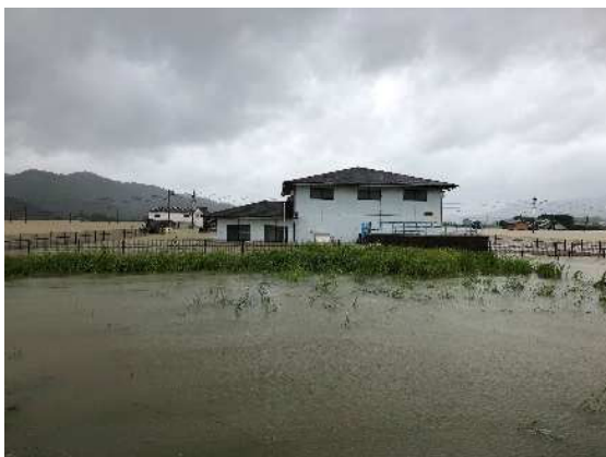
令和3年8月豪雨での湛水状況 【大町町 下瀧排水機場】
