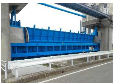
ゲートの改修 【江北町 八町地区】
