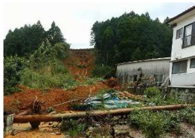
(溪間工事) 大雨による山腹崩壊 (R2)
