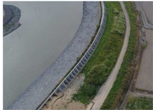
扶壁式波返工、押え捨石工 整備状況
