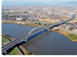
有明早津江川大橋
