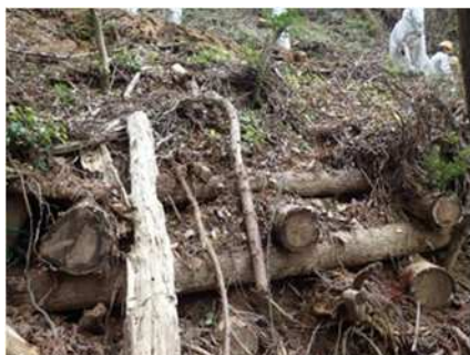
(丸太組みにより安定した盛土法面)
