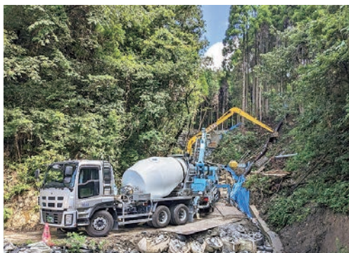
治山工事現場状況（多久市）
