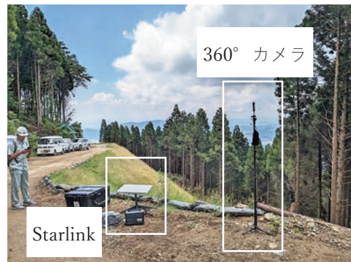
林道工事現場状況（多久市）
