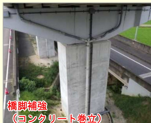
橋梁耐震化対策 実施事例
