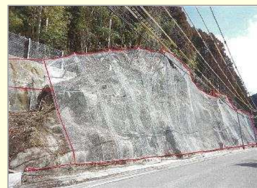
落石対策 <整備事例>
