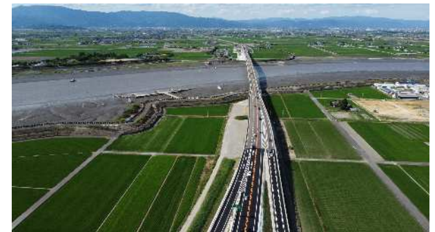
② 有明海沿岸道路 (芦刈南IC~福富IC) 令和3年7月24日開通
