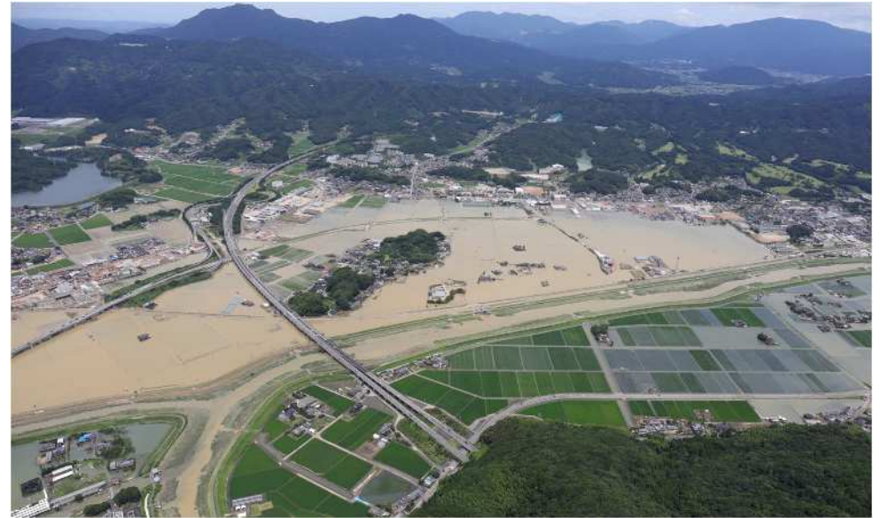
令和3年度内水氾濫状況 (武雄市)
