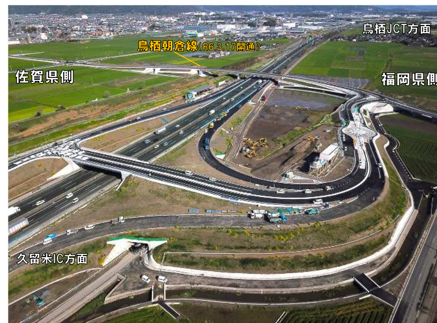
九州縦貫自動車道 小郡鳥栖南スマートIC (R6.3)
