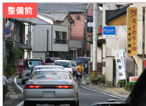
一般国道204号（旧道）
