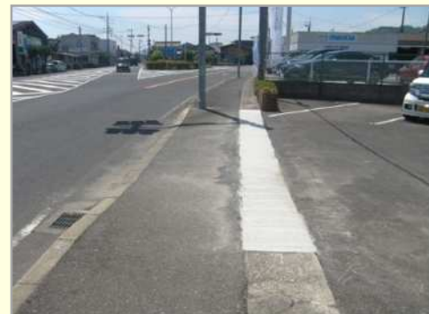
小規模補修（現場打側溝蓋設置）
