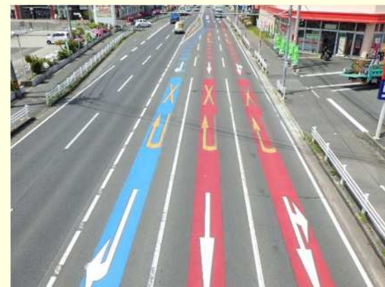
<施工例> 一般国道208号 佐大南交差点（佐賀市）
