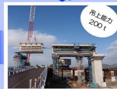
大型クレーンで架設
