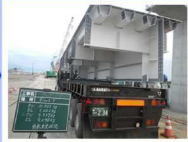
製作工場よりトレーラー輸送
