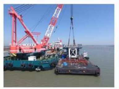
起重機船「第58茂寿号」に積込
