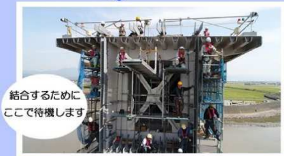
橋桁ブロックの結合部
