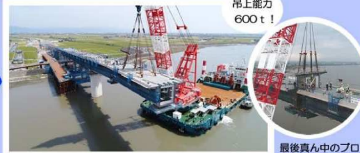
起重機船による架設
