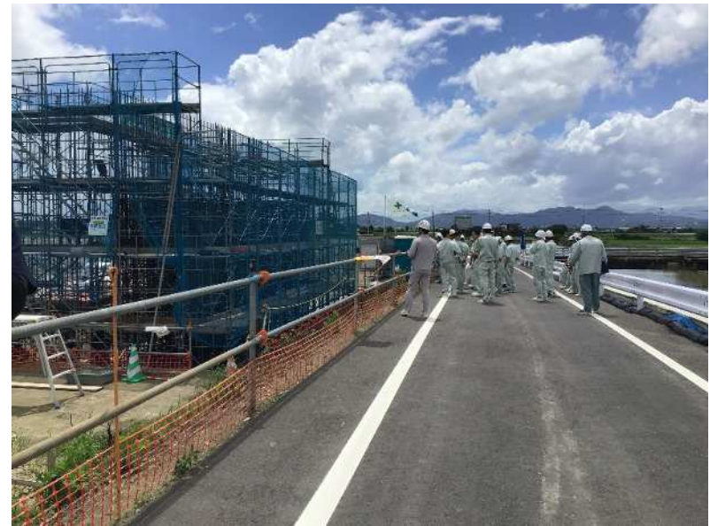
橋梁現場を見学
