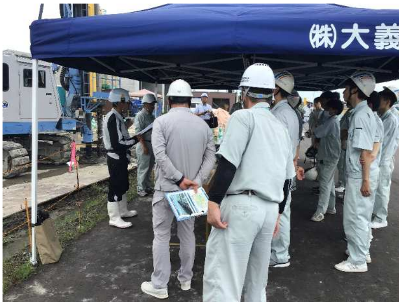
地盤改良の現場を見学
