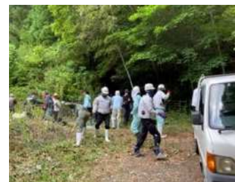
ワイヤーメッシュの補修作業
