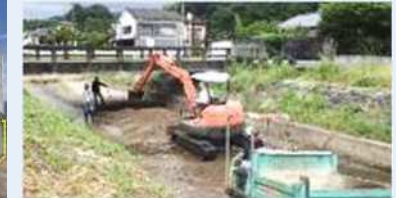
▶ 河川浚渫・伐採
