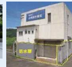
▶ 排水機場機能向上
