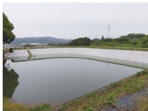
整備されたため池
