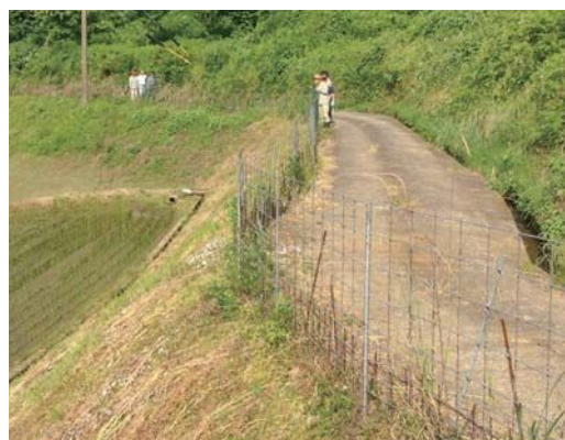
ワイヤーメッシュ柵の点検・維持管理
