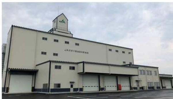
再編し、新設された共同乾燥調製施設
