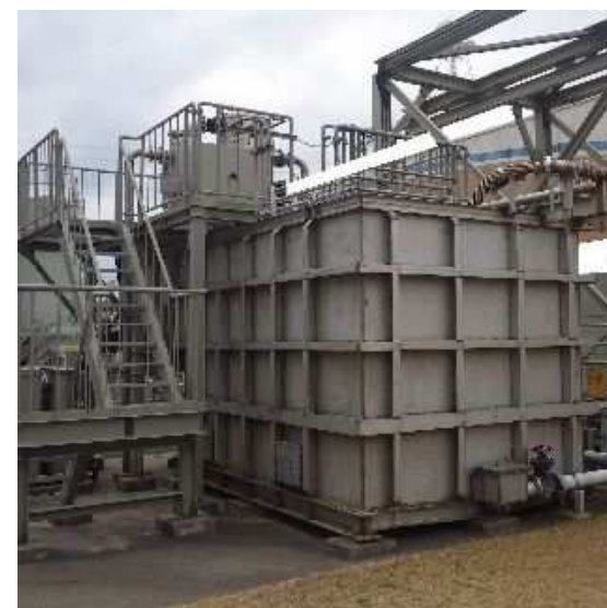
塵芥搬送装置
