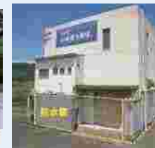
▶ 排水機場機能向上
