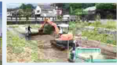
▶ 河川浚渫・伐採
