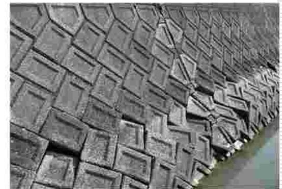
護岸（飛沫水路）の破損状況
