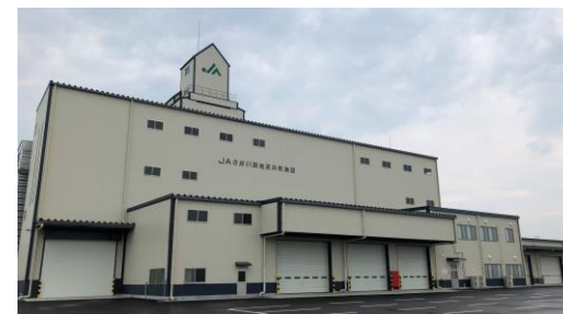
再編し、新設された共同乾燥調製施設
