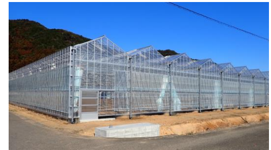
確保した優良農地での新規就農 (園芸ハウス整備)
