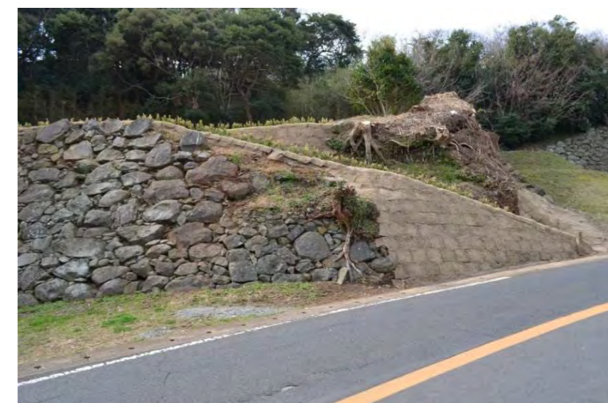
北側法面 (東から見る)
