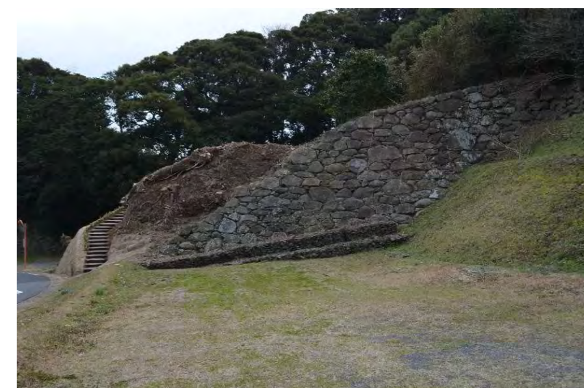
北側法面 (北西から見る)
