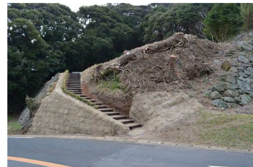
北側法面 (北から見る)
