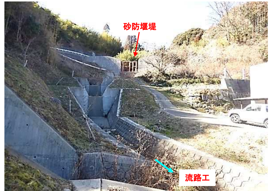
砂防堰堤及び流路工状況
