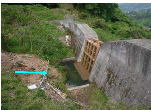
砂防堰堤背後状況(整備5年後)
