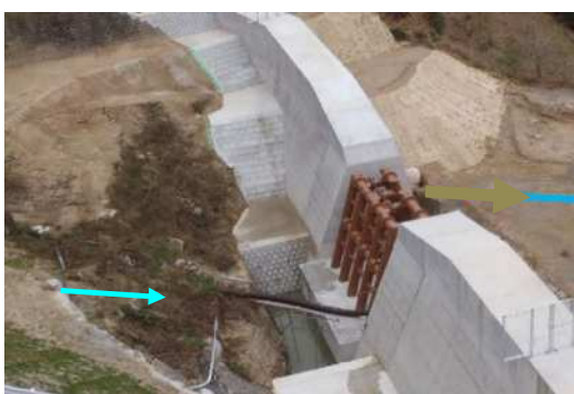
砂防堰堤背後状況(整備直後)
