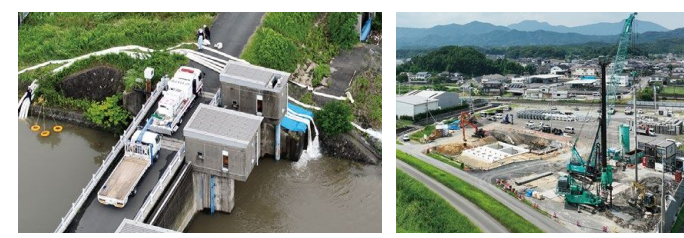
排水ポンプ車による排水の様子 広田川排水機場の施工状況
