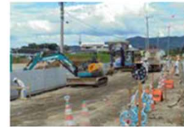
道路築造工事の土作業風景
